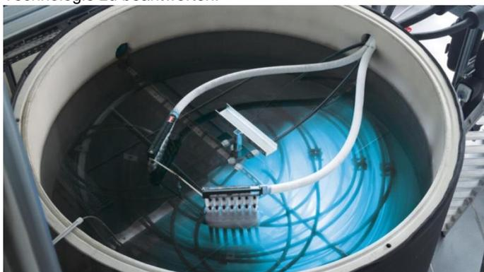
Bild: Eine Eisspeicherheizung verwandelt Eis in Wärme. Durch die entstandene thermische Energie kann ein ganzes Haus beheizt werden. Foto: viessmann.de
